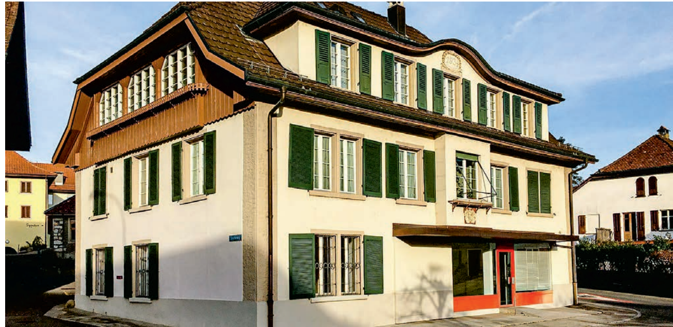
Das Begegnungszentrum entsteht in diesem Haus am Dorfplatz
