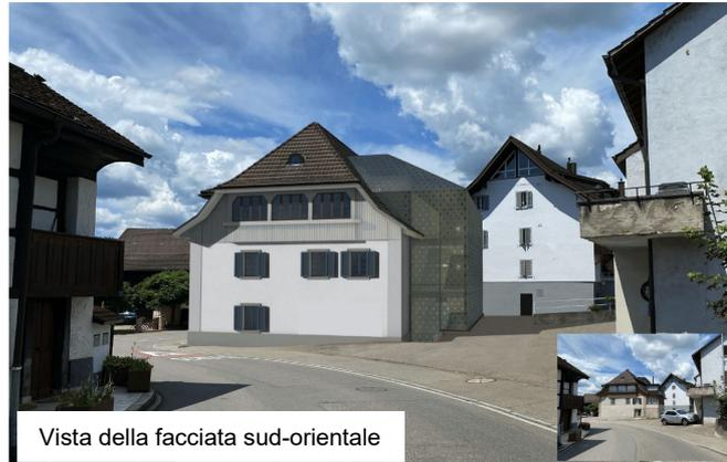
La facciata, originariamente simmetrica, viene ripristinata e integrata da una nuova area di ingresso assiale simmetrica. Le facciate dell'edificio principale vengono risanate con cura. Con un nuovo trattamento cromatico del legno viene eliminata la pesante espressione delle facciate a timpano.
